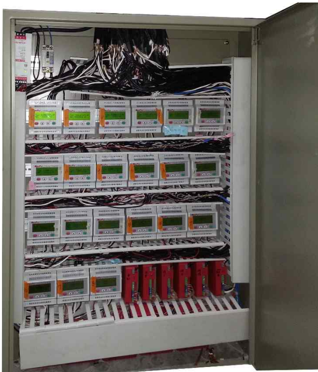
여러 대의 MU-PA 컨버터를 콘트롤 박스에 장착한 모습
